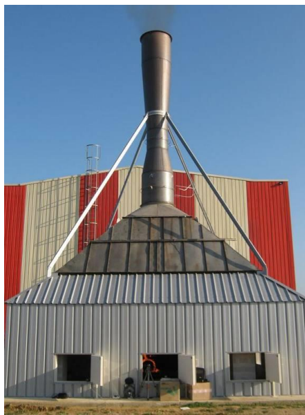
Photo 3-1 : Hotte calorimétrique d'Efectis France à Maizières-lès-Metz (57)
